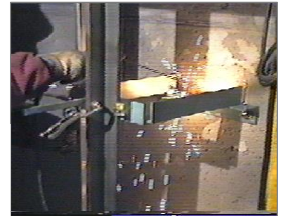
[레일 브라켓 용접]
