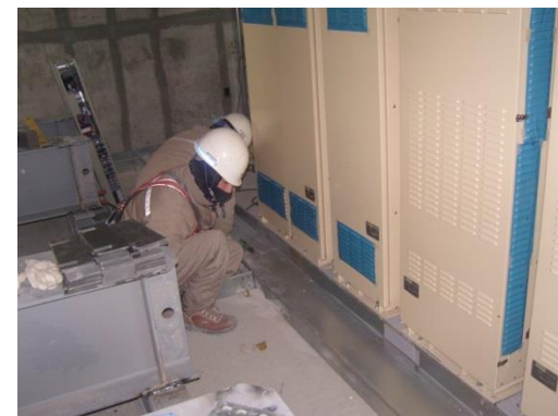
[제어반 및 전선관 설치]
